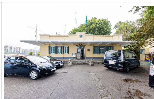
Figura 6.5.5: Fachada principal do antigo Posto de Saúde de Coloane
