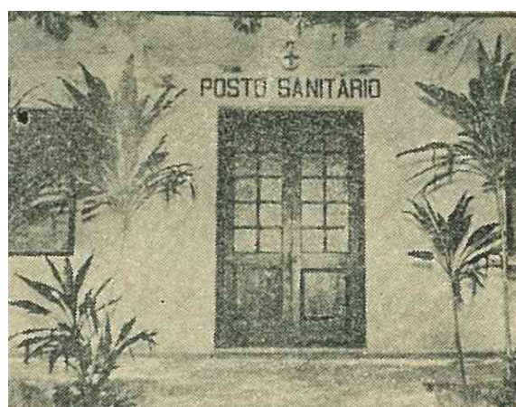
Figura 6.5.4: Vista da entrada principal do antigo Posto de Saúde de Coloane
