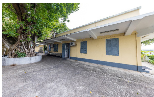
Figura 6.5.6: Vista da pala que existe em redor do edifício do antigo Posto de Saúde de Coloane
