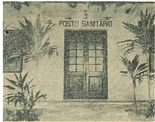
圖 6.5.4：路環衛生分站的正門位置
