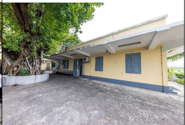
圖 6.5.6：原路環衛生分站舊址的深懸挑雨棚
