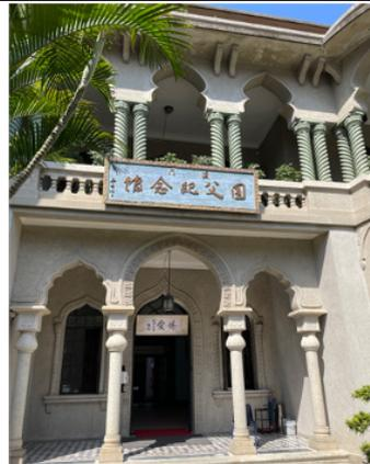
Figura 4.5.8: A fachada do edifício contém elementos típicos de arquitectura islâmica, nomeadamente, colunas de cor verde na arcada do segundo andar e diversos tipos de arcos islâmicos, incluindo arcos pontiagudos trilobulados, tumidos, festoneados e outros.
