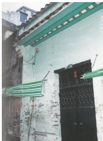
Figura 1.5.3: Entrada principal da Casa em 1994
