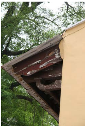
Figura 6.5.8: O dougong chinês de madeira do edifício na Rua Central n.º 47.
