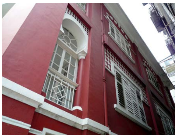
Figura 4.5.6: Fachada lateral do Edifício na Calçada do Gaio, n.º 6.
