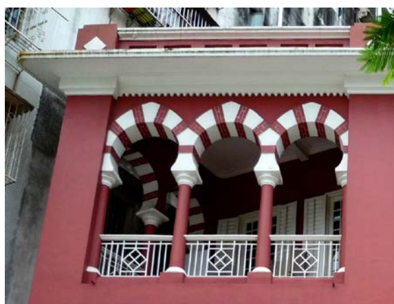
Figura 4.5.8: Os "arcos em ferradura" no 2.º andar do Edifício na Calçada do Gaio, n.º 6.
