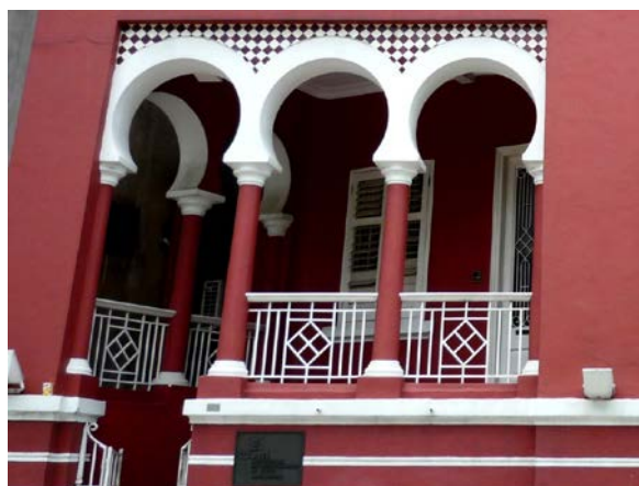
Figura 4.5.7: Os "arcos em ferradura" no 1.º andar do Edifício na Calçada do Gaio, n.º 6.
