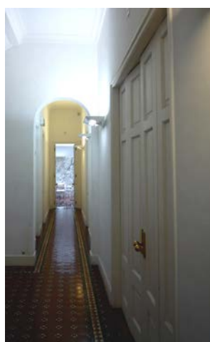
Figura 4.5.10: Espaço interior do Edifício na Calçada do Gaio, n.º 6.
