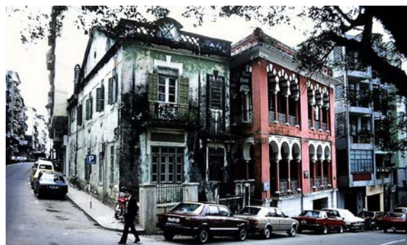
Figura 4.5.2: Na década de 70 do séc. XX, o Edifício na Calçada do Gaio, n.º 6 chegou a ser utilizado para albergar os escritórios da Polícia Administrativa.
