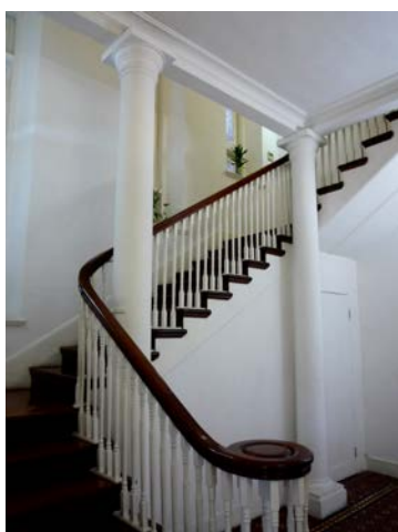
Figura 4.5.9: As escadas de madeira do Edifício na Calçada do Gaio, n.º 6.
