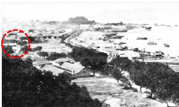
Figura 2.5.4: Zona da Av. do Almirante Lacerda e Porto Interior em 1932, com identificação do Templo de Sin Fong, a vermelho.
