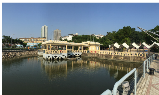
Figura 5.5.14: Actualmente, a ligação entre a Ponte-cais e o mar está bloqueada por uma nova via rodoviária.
