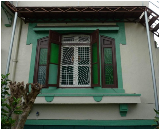
Figura 5.5.3: Pormenor de uma janela
