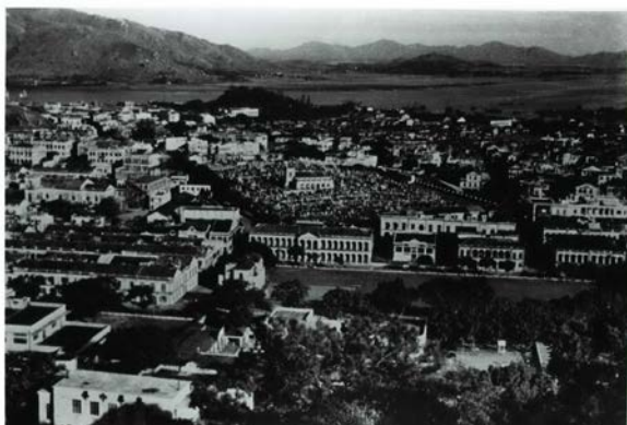
Figura 7.5.3: Fotografia histórica do Cemitério de S. Miguel Arcanjo, na qual é visível o enquadramento arquitectónico e paisagístico formado com o Bairro de São Lázaro e com a zona da Avenida do Conselheiro Ferreira de Almeida.
