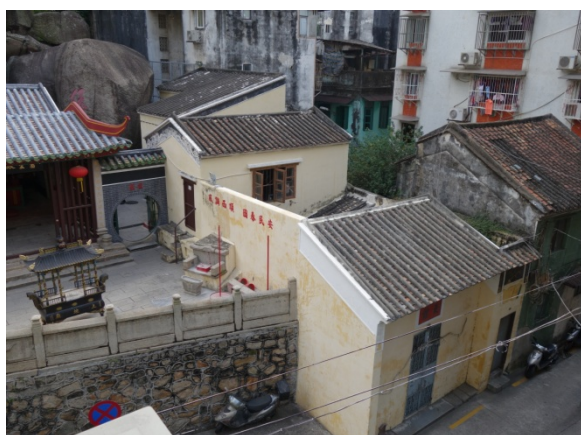
Figura 1.5.5: O Posto do Guarda Nocturno (Patane) e os edifícios contíguos construídos junto à encosta.
