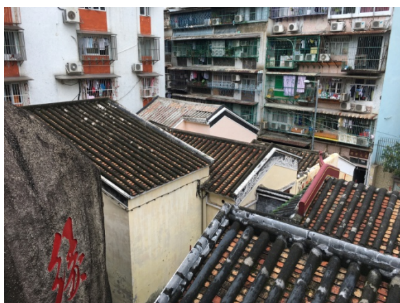
Figura 1.5.7: Fachadas laterais dos dois edifícios contíguos ao Posto do Guarda Nocturno (Patane).
