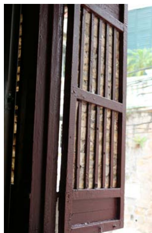
Figura 6.5.9: As janelas com lâminas de madrepérola do edifício na Rua Central n.º 47.
