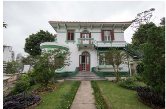
Figura 5.5.2: Estado de conservação actual
