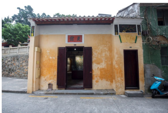
Figura 1.5.11: Aspecto actual do Posto do Guarda Nocturno (Patane).
