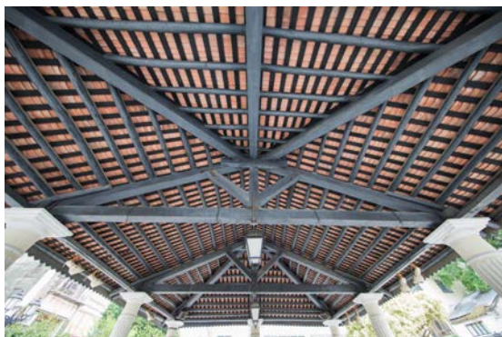
Figura 9.5.5: Estrutura de madeira da cobertura do pavilhão
