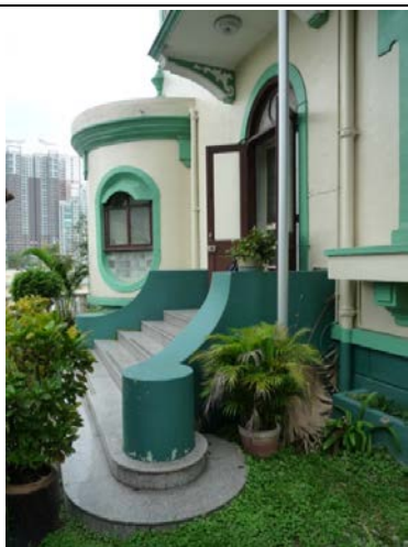
Figura 5.5.7: Entrada na fachada principal e varanda de planta circular com cobertura cônica na esquina
