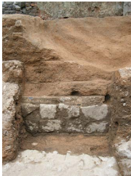
圖 3.5.4：考古清理後顯露出夯土圍牆以石塊作基礎。
