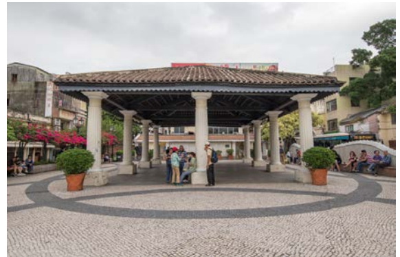
圖 9.5.6：嘉模墟石柱及屋頂。
