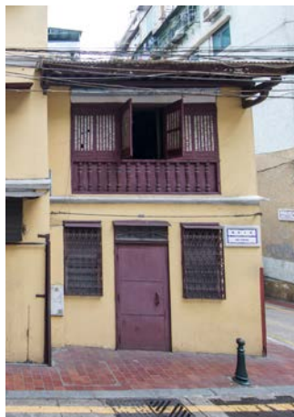
圖 6.5.7：龍嵩正街 47 號房屋現況。
