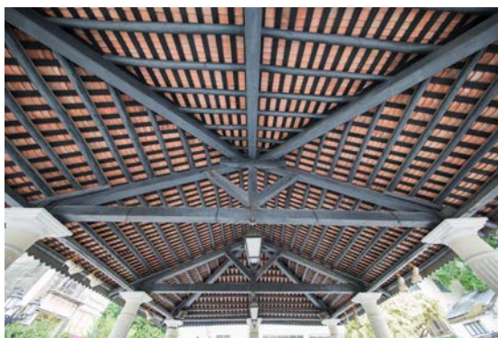
圖 9.5.5：屋頂之桁架。
